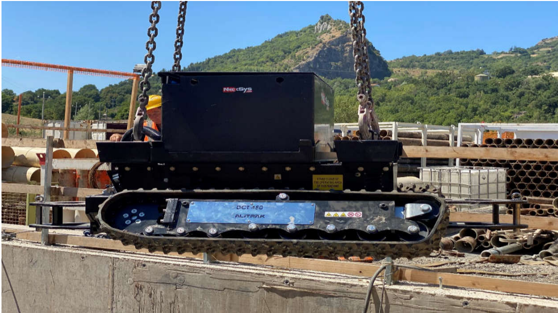
Figure 4 – Manutention du DCT450MT dans le puits de poussée
