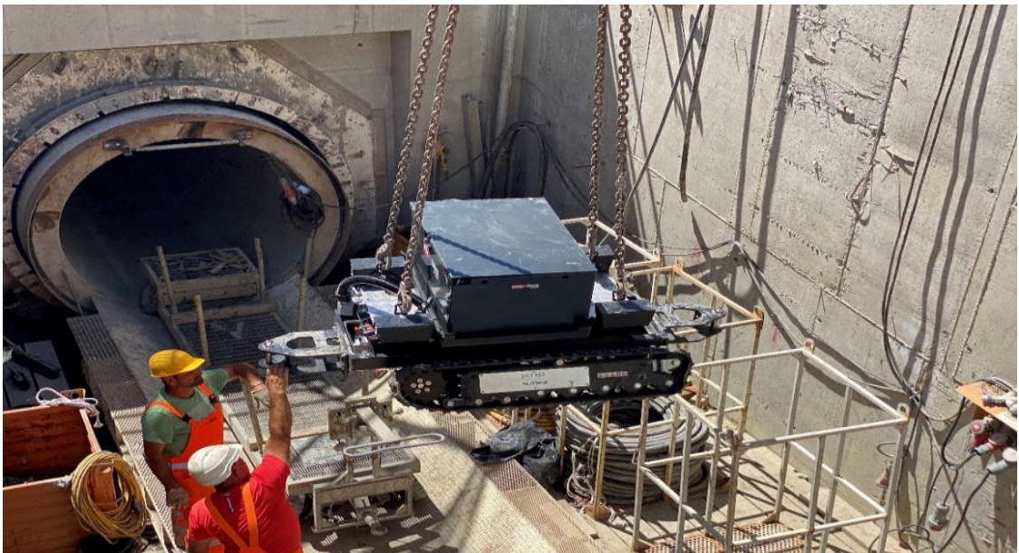
Figure 5 – Manutention du DCT450MT dans le puits de poussée
