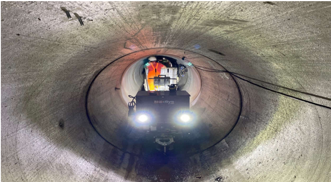
Figure 6 - DCT450MT en action dans le microtunnel
